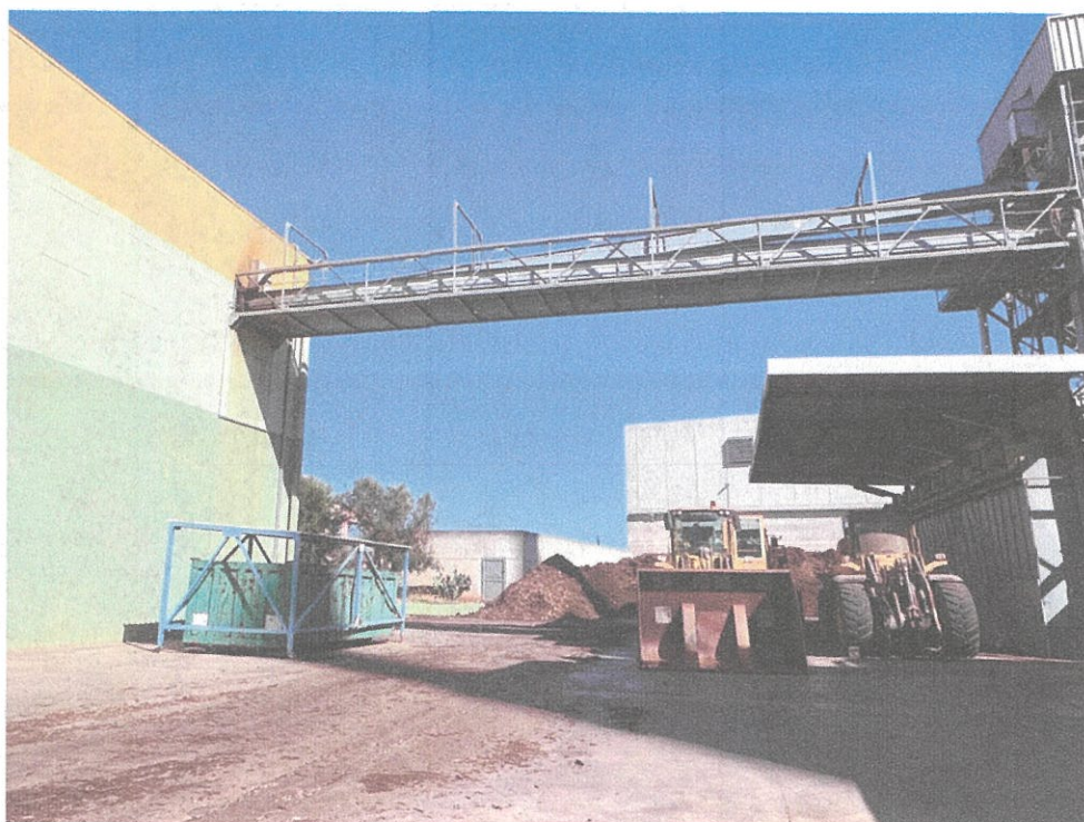
stoccaggio esterno del materiale rimosso
