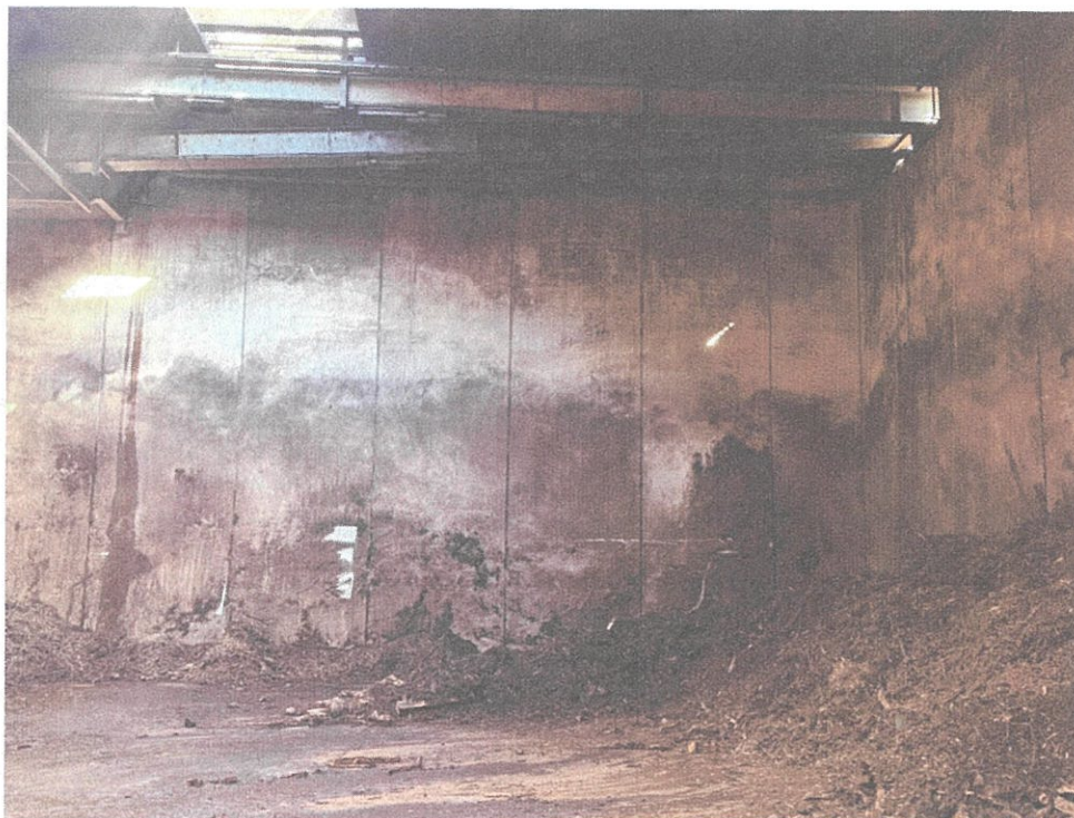
interno del capannone
